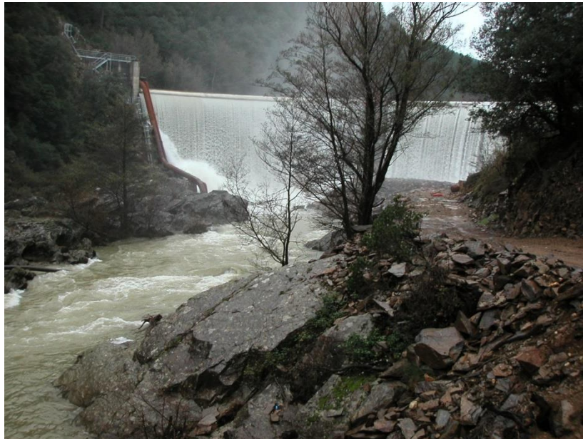
Figure 72: Surverse du barrage lors des travaux de 2002/2003
