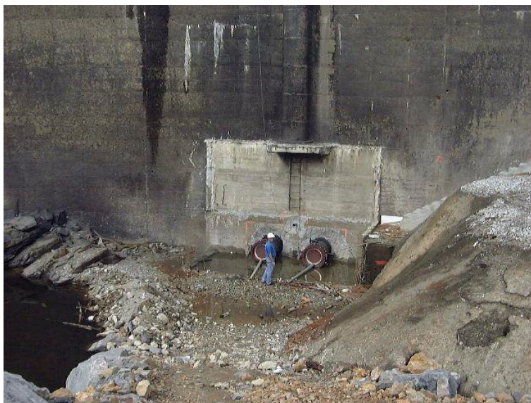
Figure 73: Rampe d'accès au bassin lors des travaux de 2002/2003
