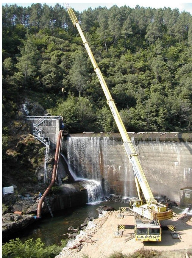
Figure 74: Plateforme de travail lors des travaux de 2002/2003
