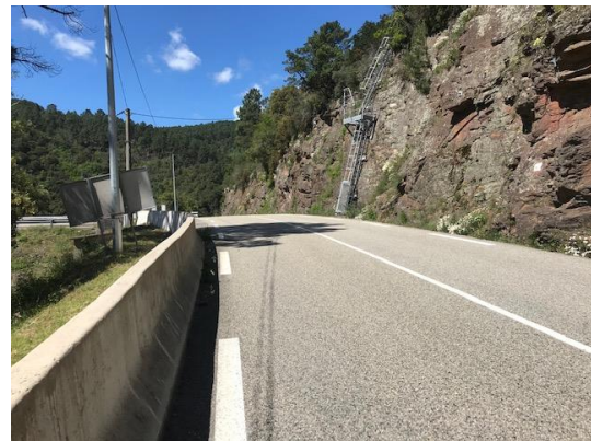
GBA existante depuis portail d'accès
