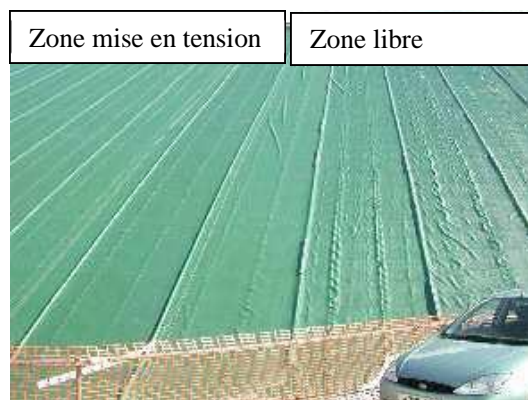
Figure 15 : Principe de tensionnement de la membrane (Source : CARPI)
