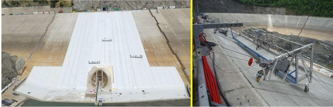
Figure 22 : Nacelles suspendues mobilisées dans le cadre des travaux sur La Coche en 2018 (source : CARPI)
