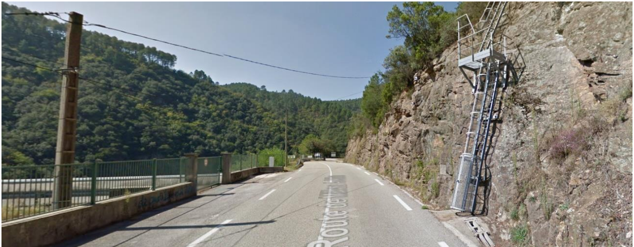
Figure 2 : Vue depuis l'aval de la RN106 et de l'extrémité RG de l'axe du barrage
