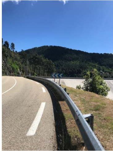
Glissière de sécurité à l'amont du barrage
