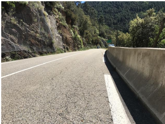
GBA existante côté aval du barrage
