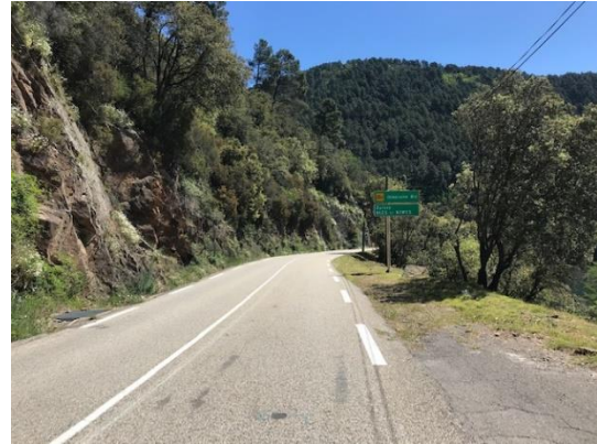
RN106 au droit du barrage vers Alès
