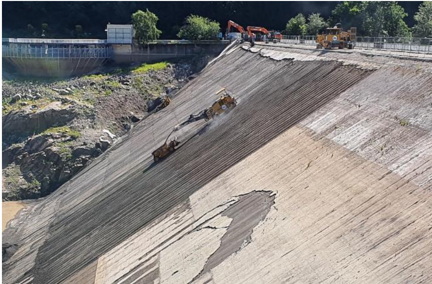
Figure 10 : Travaux de rabotage du masque existant de Kruth, avant réfection (2020)
