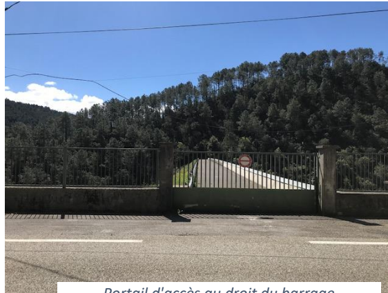
Portail d'accès au droit du barrage
