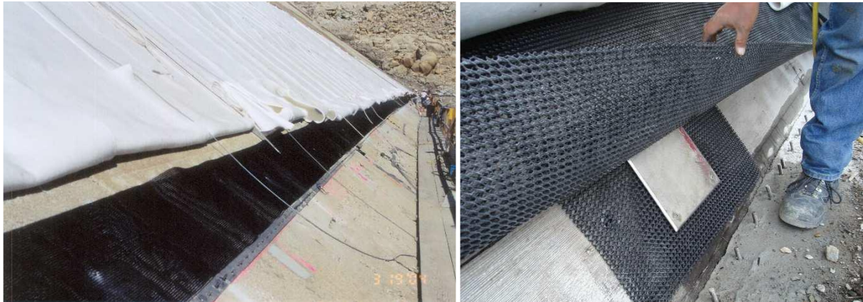
Figure 20 : Détails de bande de géodrain additionnelle en pied d'ouvrage (barrage de Salt Springs, Etats Unis 2005, à gauche) et de plaque anti-intrusion (barrage de Sabrina, Etats Unis 2006, à droite) – source : CARPI
