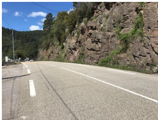
Boucle de détection sous chaussée
