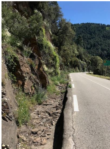
Fossé bétonné côté falaise
