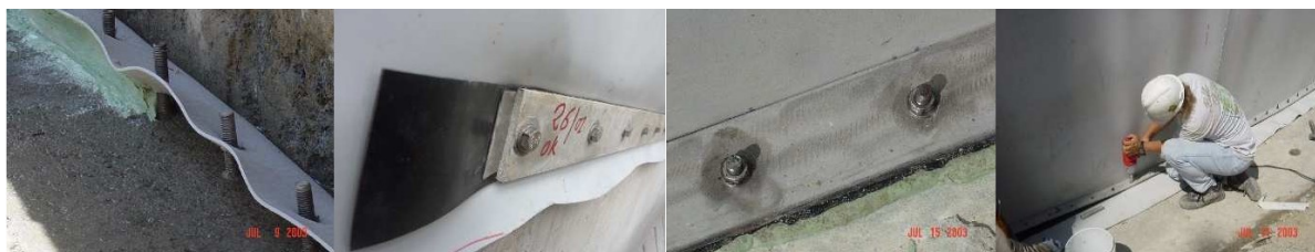
Figure 3-30 : Fixation étanche (de gauche à droite : résine d'assise, garniture caoutchouc, fer plats inox, mise en œuvre des ancrages) – source : Carpitech
