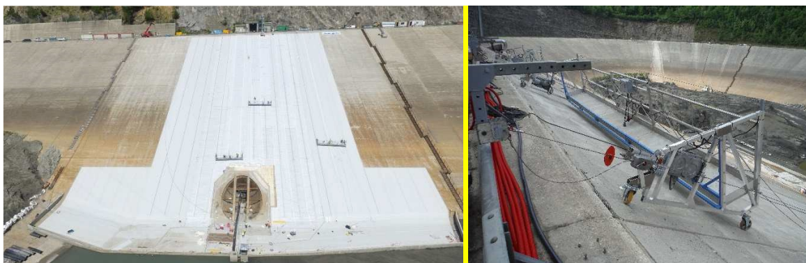
Figure 3-34 : Nacelles suspendues mobilisées dans le cadre des travaux sur La Coche en 2018 (source : Carpitech)
