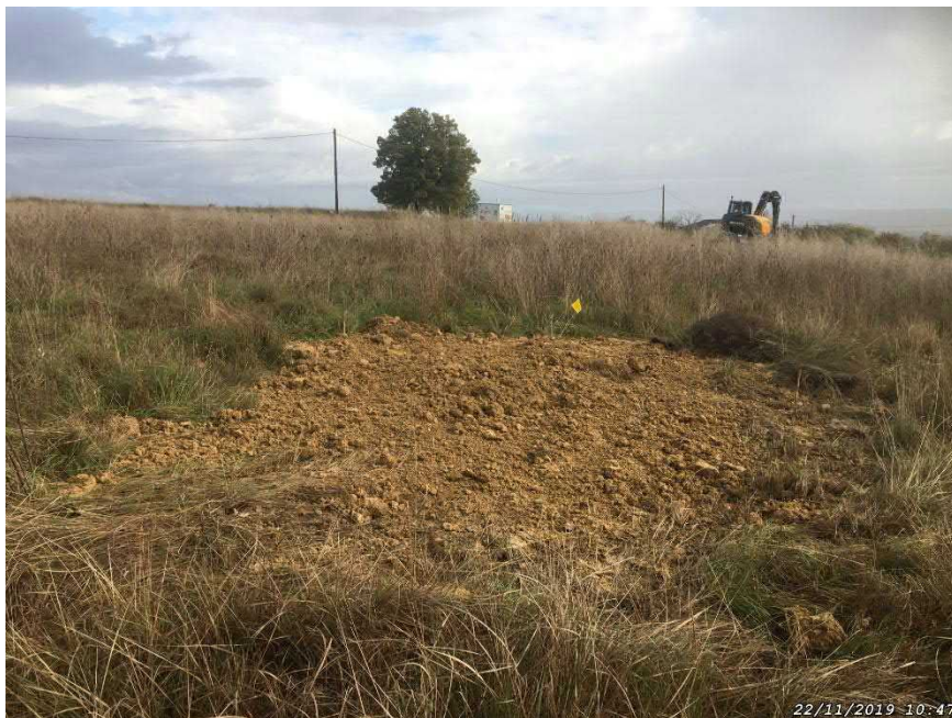
Photo 10. Sondage MAR1-101_S3 rebouché
