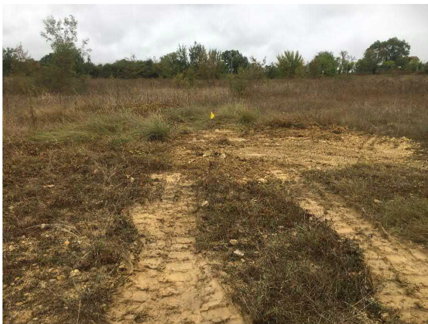
Photo 22. Sondage MAR1-101_S9 rebouché
