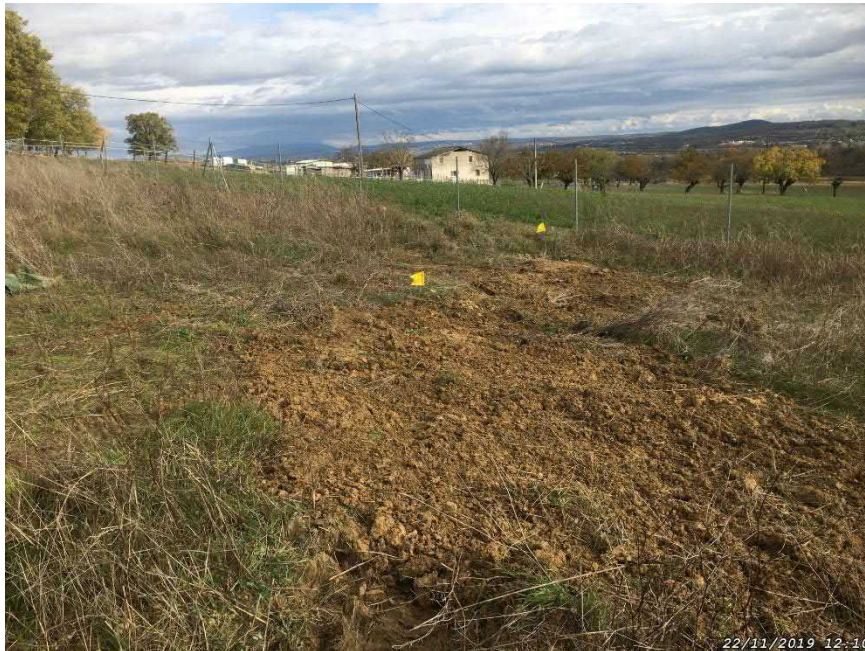
Photo 16. Sondage MAR1-101_S5bis rebouché
