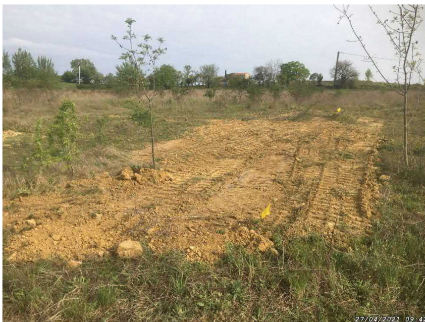
Photo 36. Tranchée MAR1-101_T7 rebouchée
