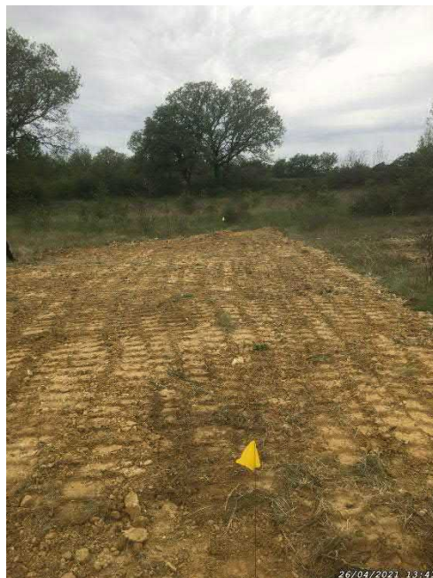
Photo 30. Tranchée MAR1-101_T4 rebouchée
