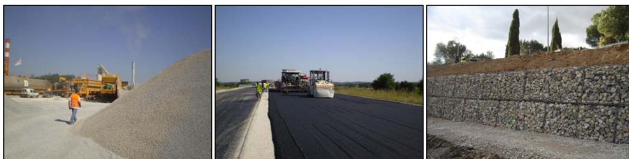
Chantier RN 106 : stocks centrale d'enrobés, sous-couche chaussée, Gabions
