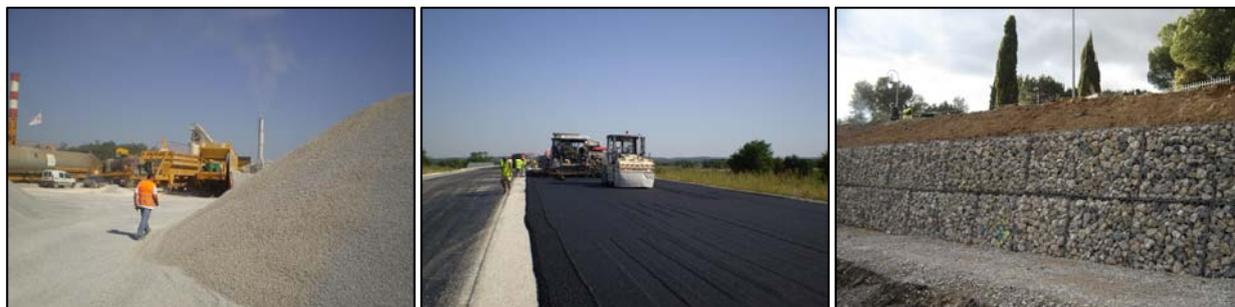
**Chantier RN 106 : stocks centrale d'enrobés, sous-couche chaussée, Gabions**
