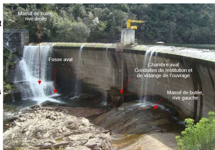
Figure n°8 : principales interventions sur le barrage
