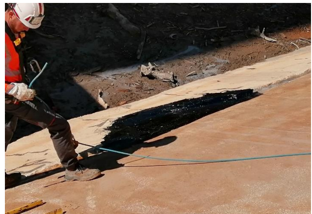
Photo 70 : Réparation de la partie de couvre-joint arrachée
