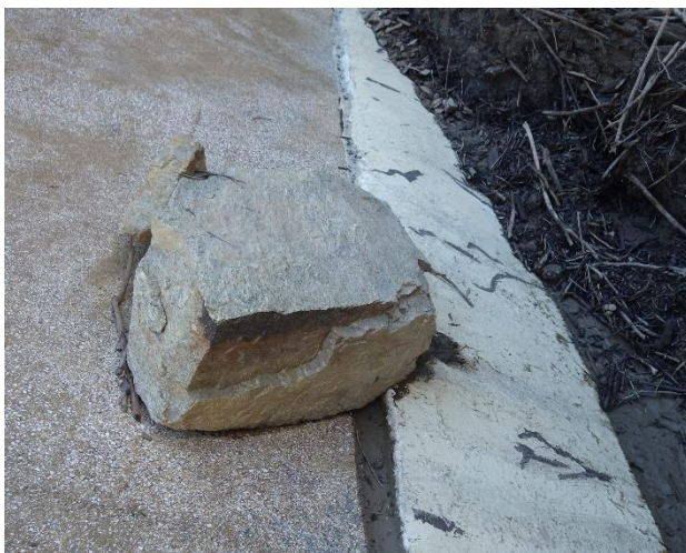
Photo 55 : Défaut n°29 – Rocher sur le parement (vue depuis la RG)
