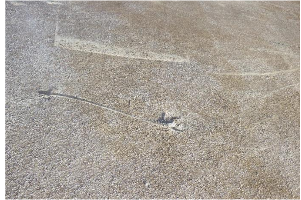
Photo 62 : Défaut n°9 – Dégâts de déboisement constatés en 2013
