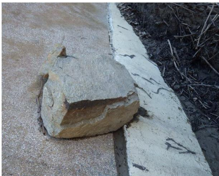
Figure 24 : Bloc rocheux tombé sur le masque
