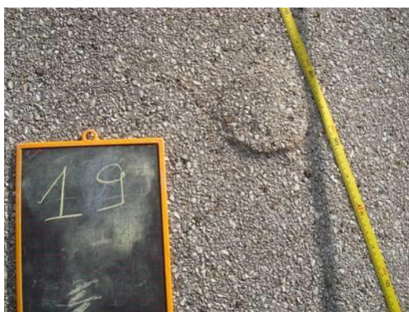
Photo 21 : Défaut n°20 – Forage rebouché sur la bande n°19 (à gauche : 2020 ; à droite : 2013)
