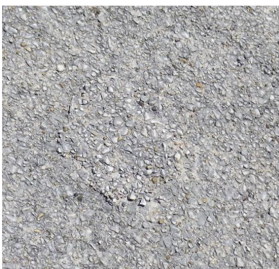
Photo 22 : Défaut n°22 – Forage rebouché sur la bande n°18 (à gauche : 2020 ; à droite : 2013)
