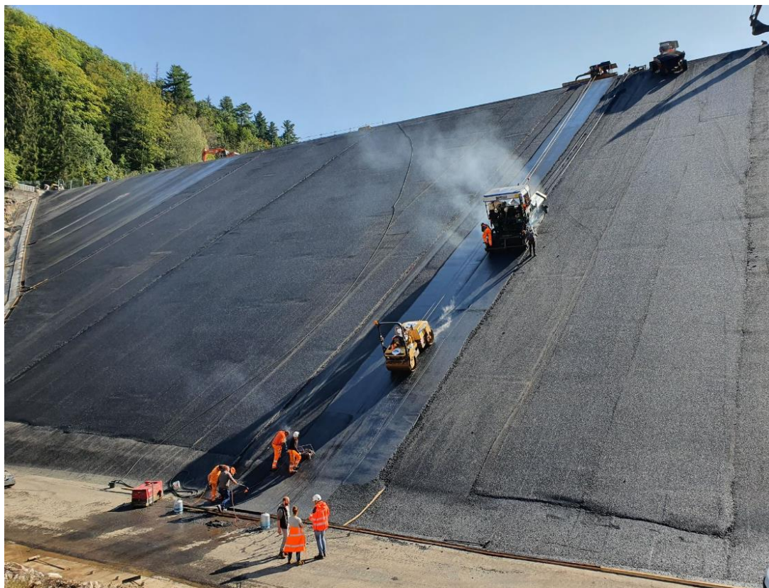
Figure 57 : Mise en œuvre de la couche étanche supérieure sur la couche drainante
