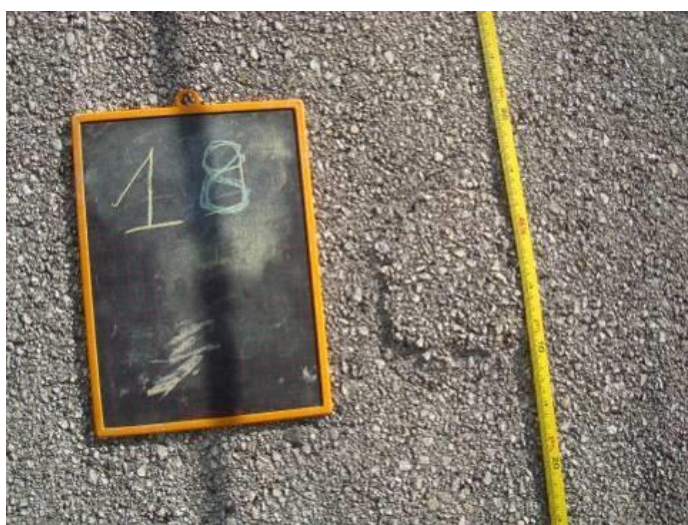
Photo 22 : Défaut n°22 – Forage rebouché sur la bande n°18 (à gauche : 2020 ; à droite : 2013)
