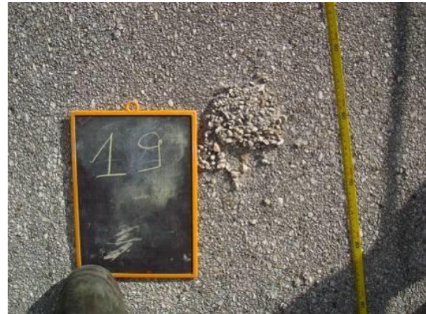
Photo 20 : Défaut n°21 – Forage rebouché sur la bande n°19 (à gauche : 2020 ; à droite : 2013)
