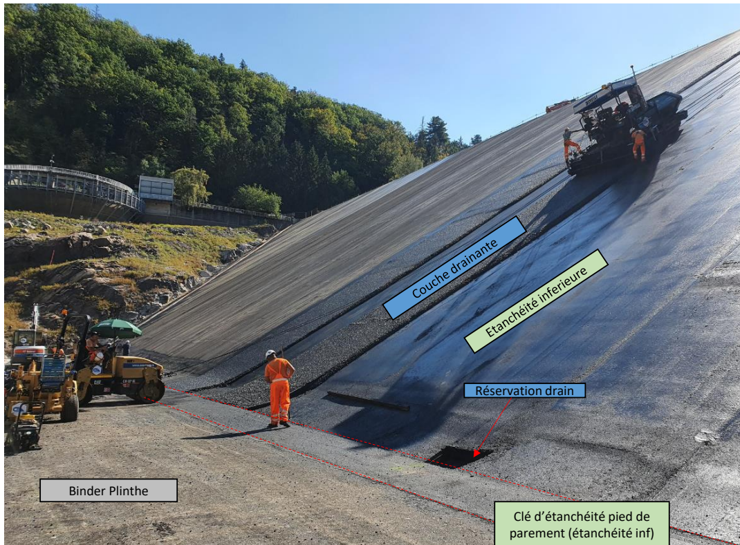
Figure 56 : Mise en place de la couche drainante sur la couche d'étanchéité inférieure
