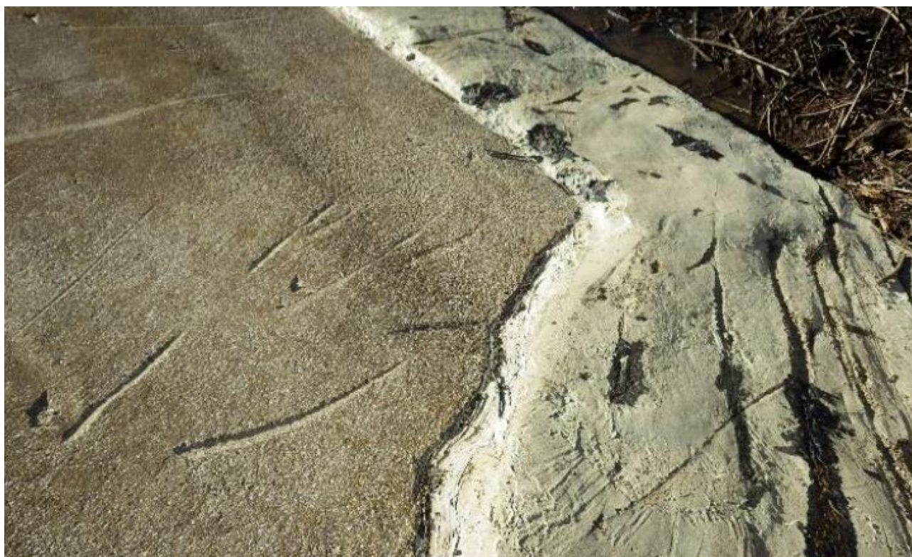
Figure 25 : Désordres liés aux retraits des embâcles
