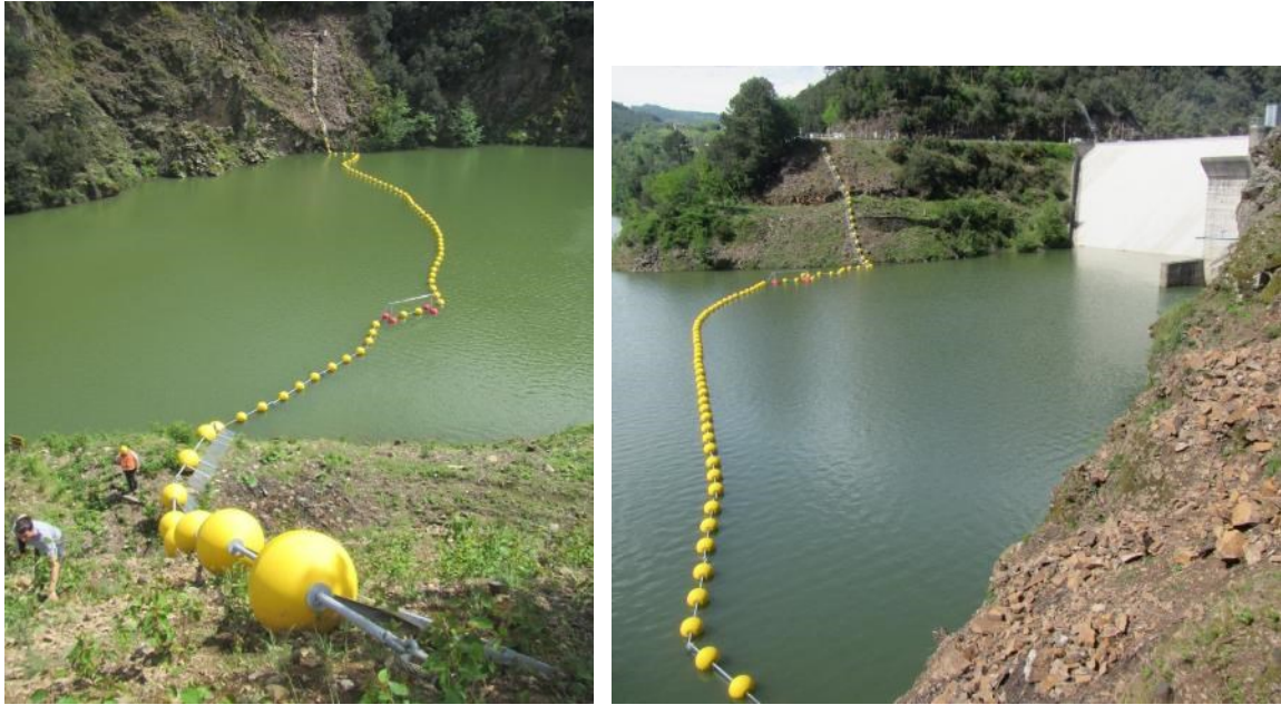
Figure 5 : Vues de la drome en fin de chantier (ISL, 2015)
