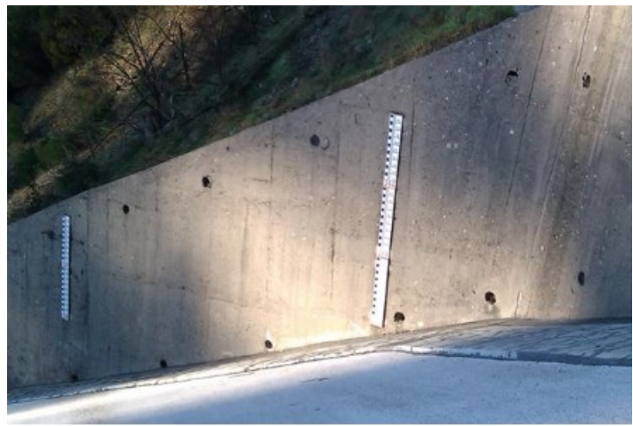
Figure 20 : Vue des échelles limnimétriques présentes sur le barrage (à gauche sur la tulipe, à droite sur le parement amont)
