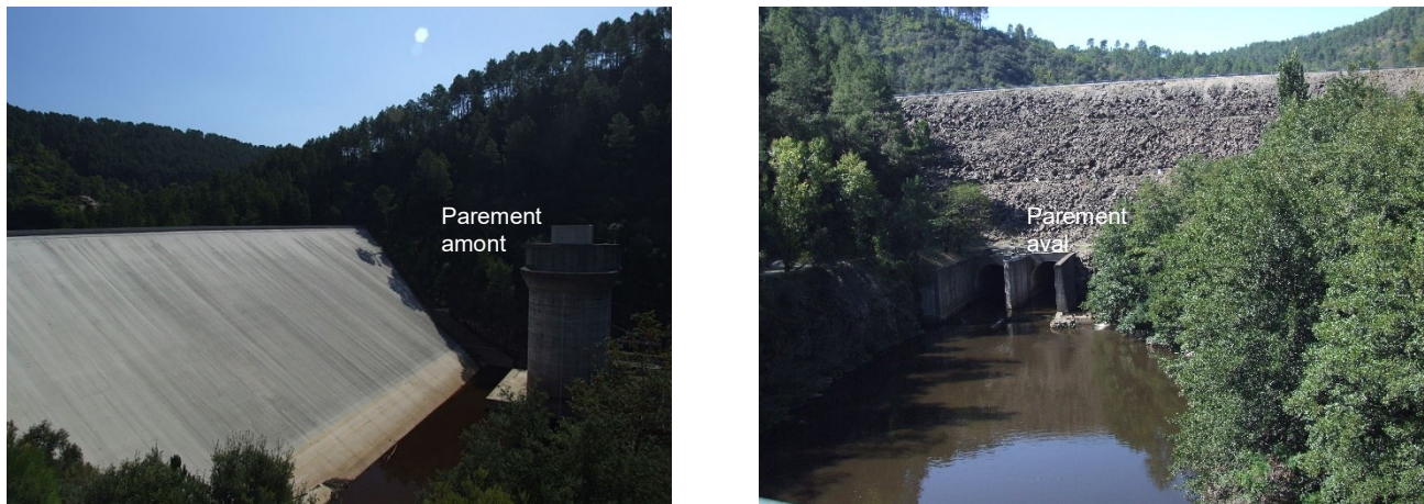
Figure 10 : Vues des parements amont et aval du barrage
