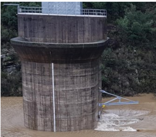
Figure 20 : Vue des échelles limnimétriques présentes sur le barrage (à gauche sur la tulipe, à droite sur le parement amont)
