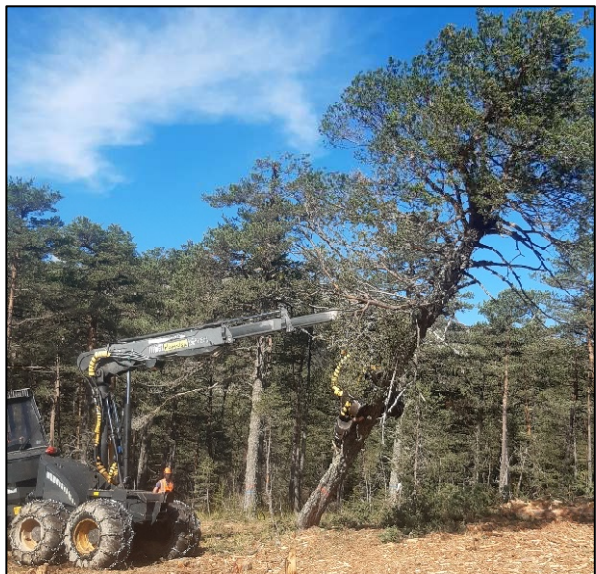
Abattage à l'aide d'une abatteuse et d'une tronçonneuse
