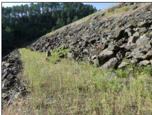
Enrochements sur le barrage de Sainte-Cécile, exploités par le Lézard catalan
