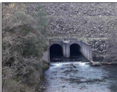
Les galeries de fuite du barrage de Sainte-Cécile-d'Andorge sont des sites de nidification favorables
