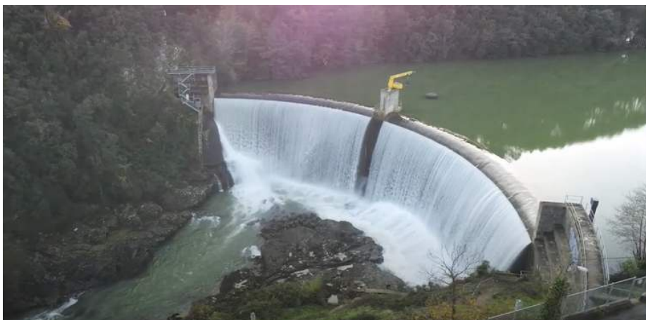
Photographie 4 : Le barrage des Cambous
