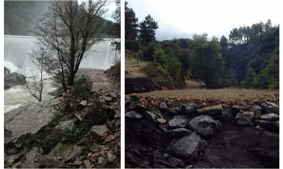
Photographie 17 : Plateforme et piste d'accès créer pour les travaux de 2002 / 2003
