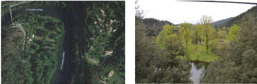
Vues de la station aval 3 – Aval éloigné du barrage de Sainte-Cécile d'Andorge
