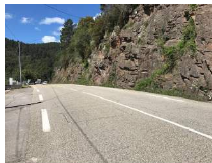
RN106 au droit du barrage vers Mende
