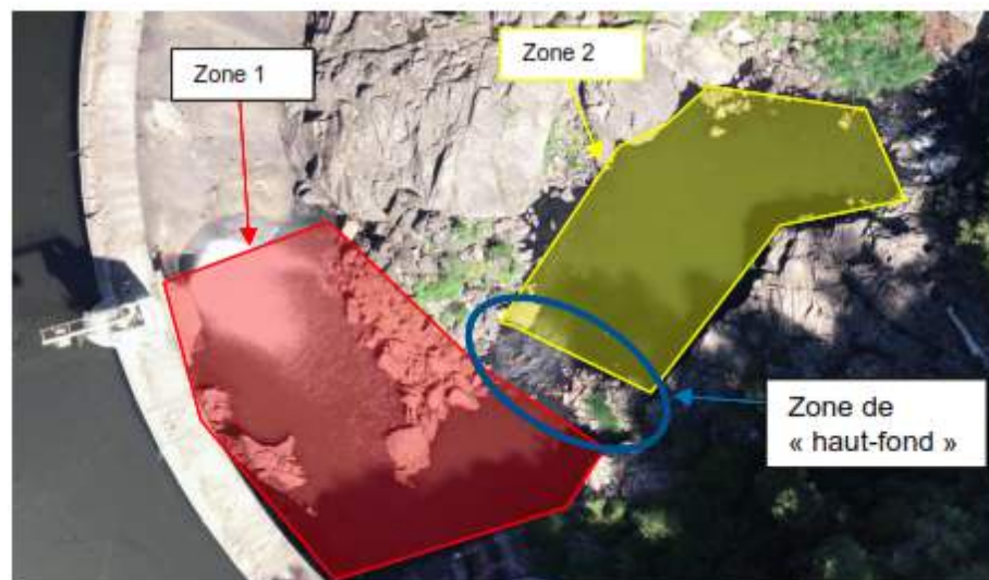
Figure 47 : Zone d'intervention au droit du barrage des Cambous
