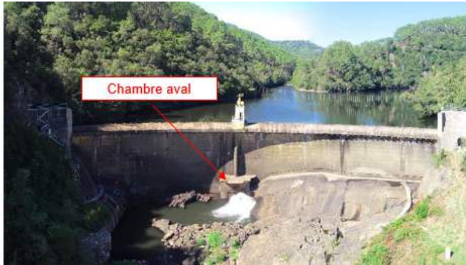
Figure 28 : Chambre aval du barrage des Cambous
