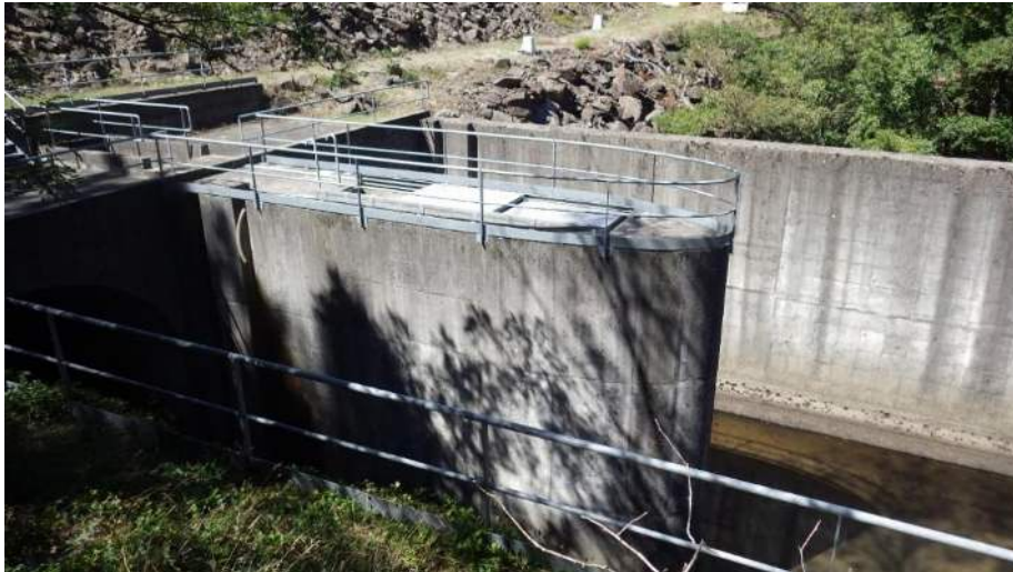
Photographie 8 : Chambre de restitution aval, vue depuis l'aval du barrage
