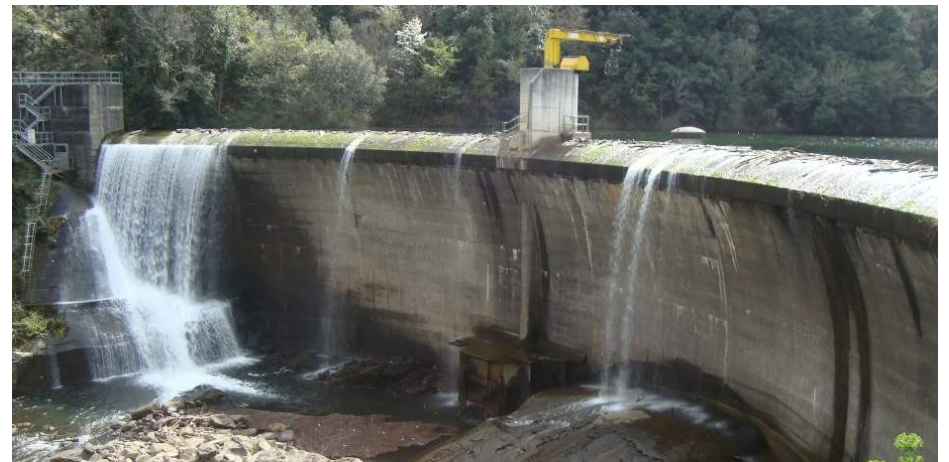
Photographie 3 : Le barrage des Cambous (avril 2019)
