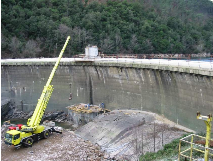
Photographie 16 : Plateforme de travail des travaux de 2002/2003
