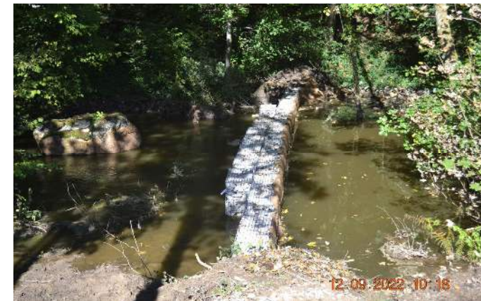
Photographie 19 : Dispositif de barrage filtrant mis en œuvre dans le cadre de la vidange du barrage des Settons (maîtrise d’œuvre ISL-EGIS)
