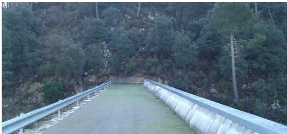
Photographie 5 : Vue sur la crête du barrage de Sainte-Cécile d'Andorge depuis la Route Nationale 106 (à droite, partie amont de l'ouvrage)
