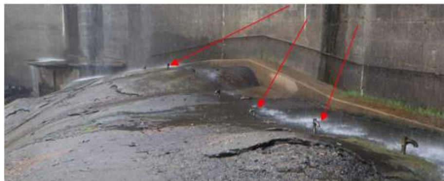
Figure 27 : Drains actuellement observables au droit du massif de butée du barrage de Cambous
