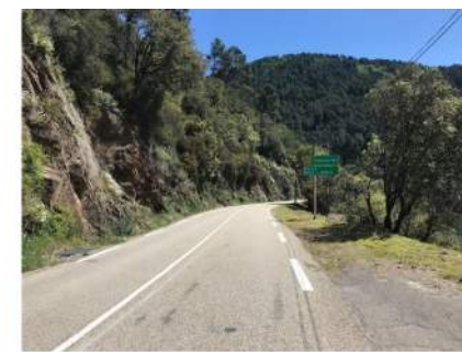
RN106 au droit du barrage vers Alès
