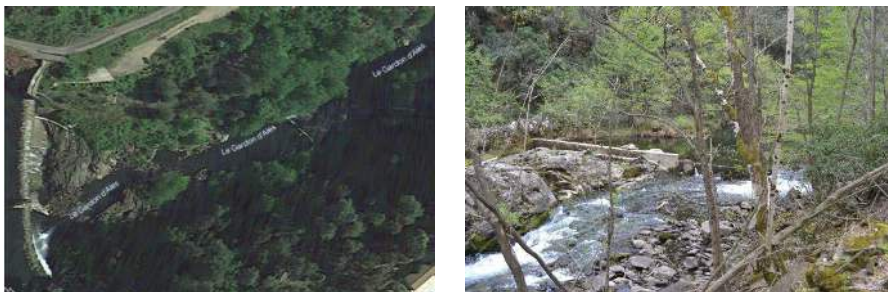
Vues de la station aval 4 – Aval du barrage des Cambous et du seuil bétonné
