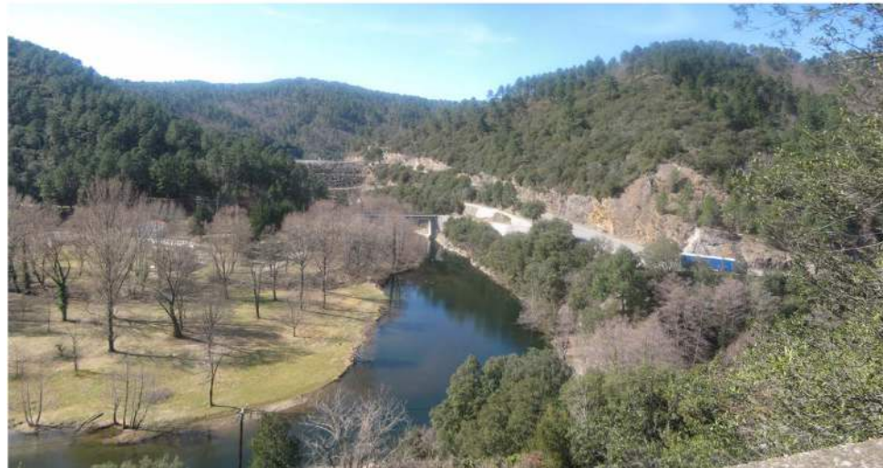
Figure 63 : Aménagements écologiques et paysagés au droit du Site des Deux Lacs, après repli des installations de chantier (État actuel et État aménagé)
