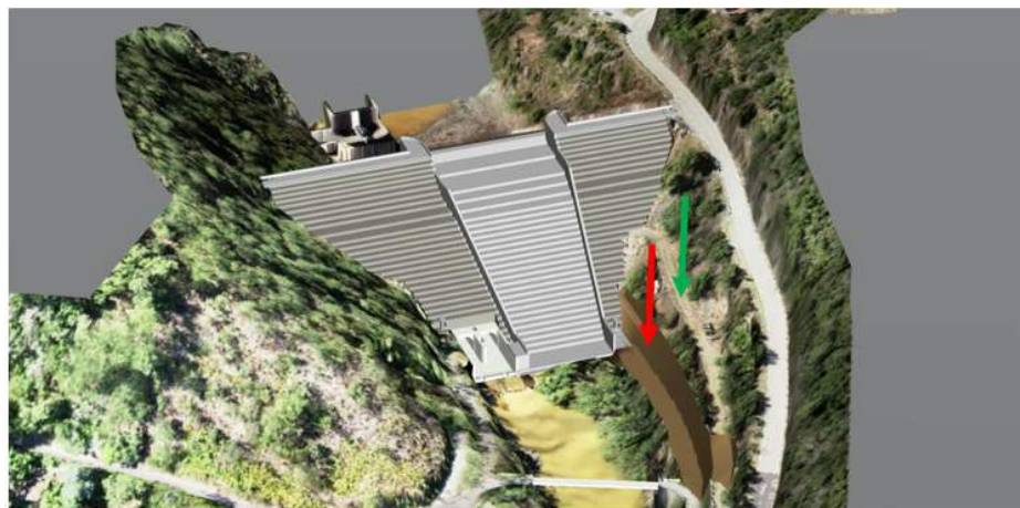
Figure 18 : Création d'un accès au barrage en rive gauche (flèche rouge) et confortement de la piste existante (ancienne RN 106) (flèche verte)
