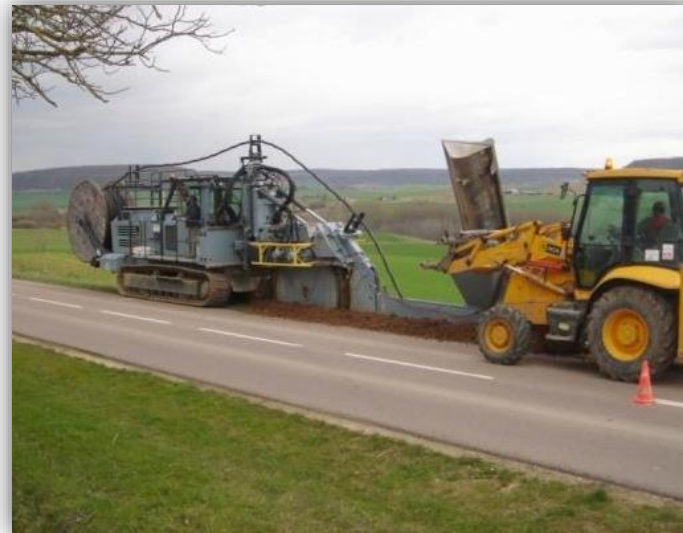
Réalisation d'une tranchée d'enfouissement des câbles de raccordement au réseau public de distribution d'électricité
