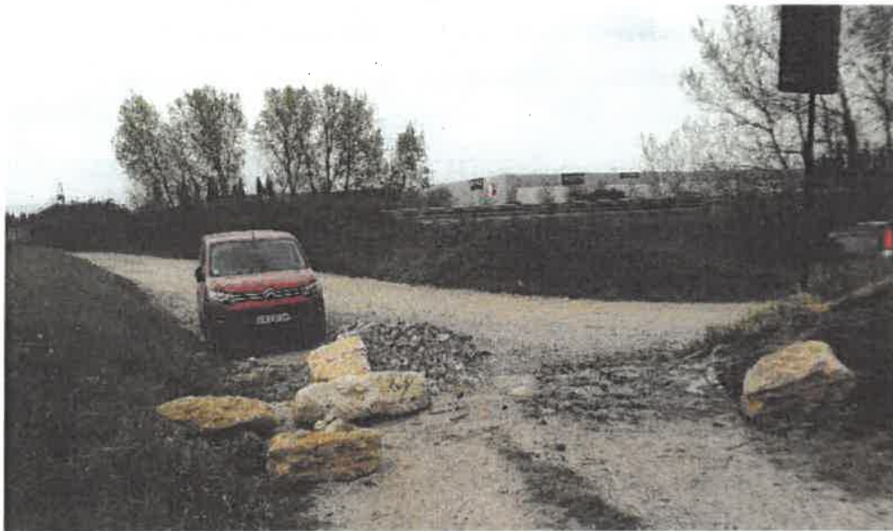
Blocs de pierre limitant normalement l'accès situé au nord du bassin, déplacés et non fonctionnels – CBE, 26 mars 2021
