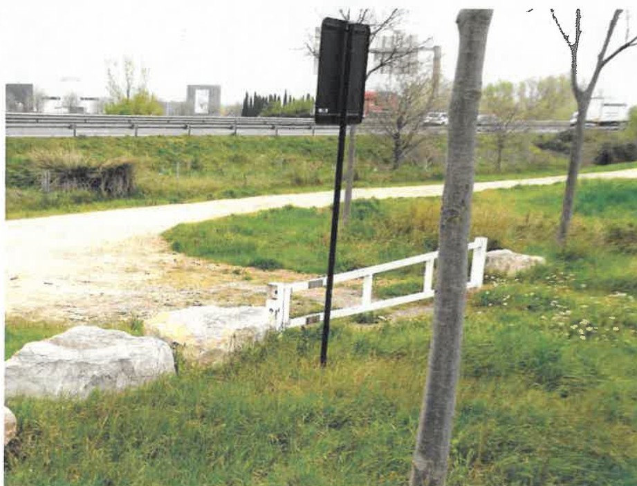
Exemple de barrière pivotante en métal installée au nord-est du site – CBE, 26 mars 2021
