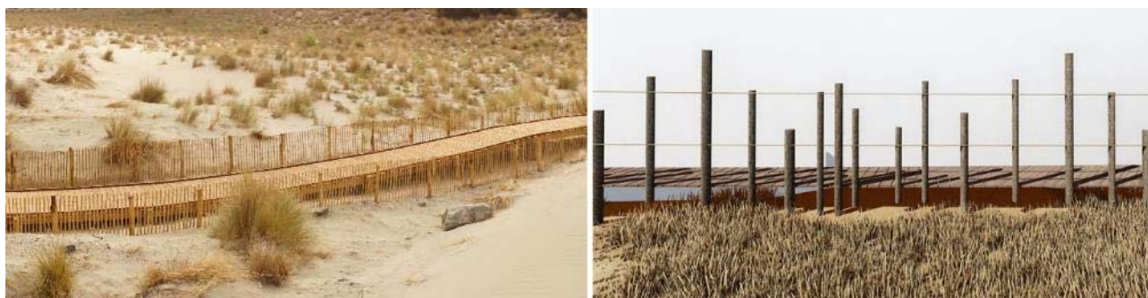
Figure 17 : Illustrations d'un chemin sur platelage dans les dunes A gauche : Ouvrage existant à Beauduc (13) ; A droite : Principe du garde-corps
