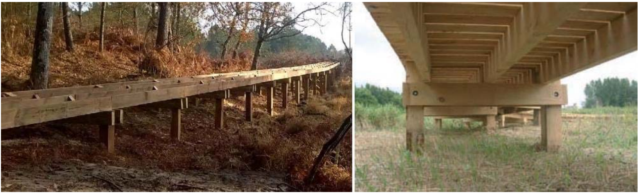
Figure 18 : Exemple de structure porteuse de platelage
