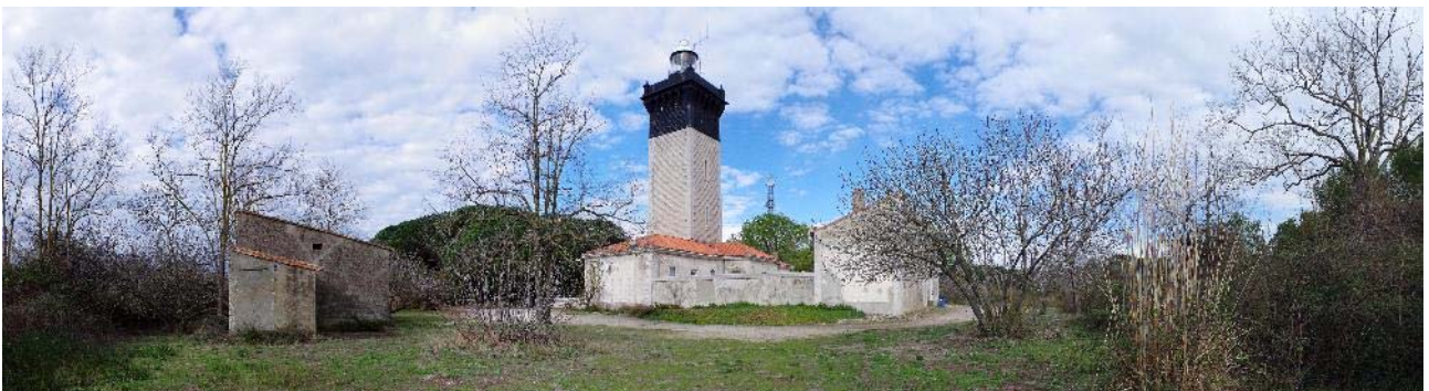
Photo 10 : Les bâtiments du phare vus depuis le sud - A gauche, le local de la future entrée
