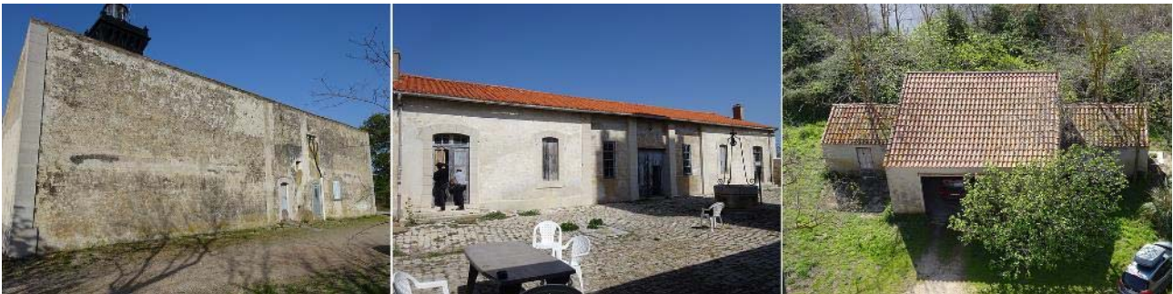
Figure 7 : Bâtiments annexes du phare
