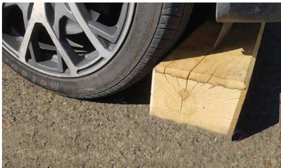
poutre chêne de démarquation des places de parking (sur revêtement stabilisé)
