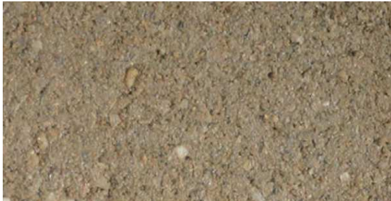
Détail d'un revêtement stabilisé
