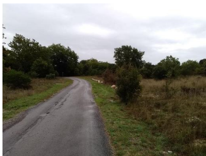
Végétation attenante à la chaussée, présence de taillis, lande boisée et garrigue.
