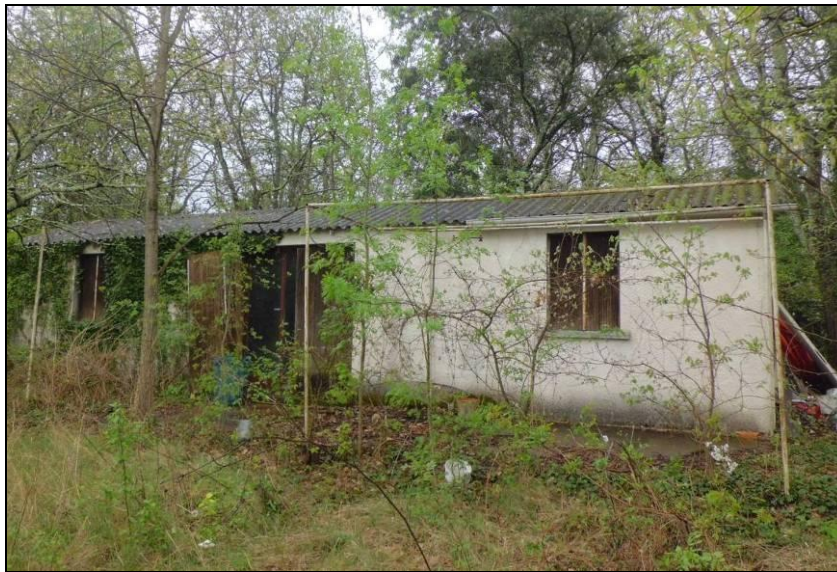
Figure 21 : Vue du bien concerné (photo prise lors de la visite du 8 avril 2014, Safège)
