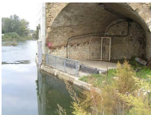
Prise d'eau canal de Boucoiran (site station Ners)
