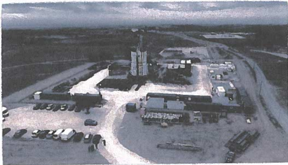
Vue aérienne d'une plateforme de forage
