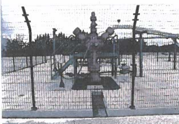
Tête de puits avec fosse et collecte des égouttures Collecte des égouttures de la plateforme
