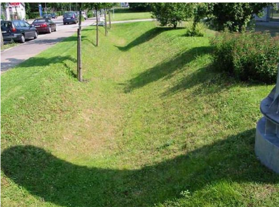
Photographie 3 : fossé enherbé en bordure de voirie
