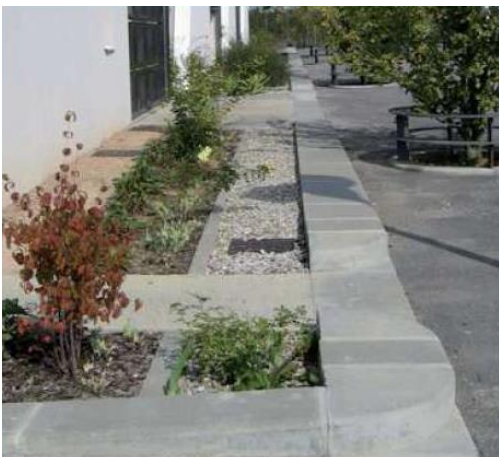
Photographie 4 : tranchée d'infiltration
