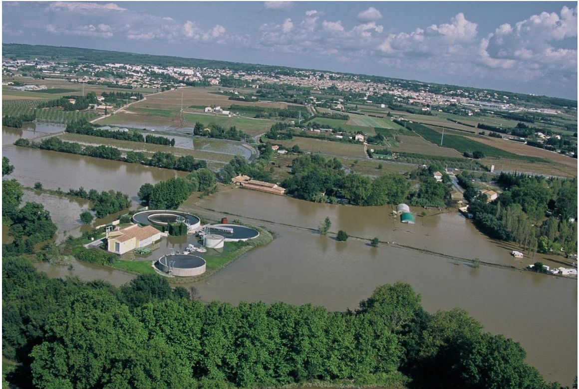
Plaine du Vistre, en septembre 2005, la station d'épuration et le camping de Vauvert sont submergés (cliché DDE 30).
