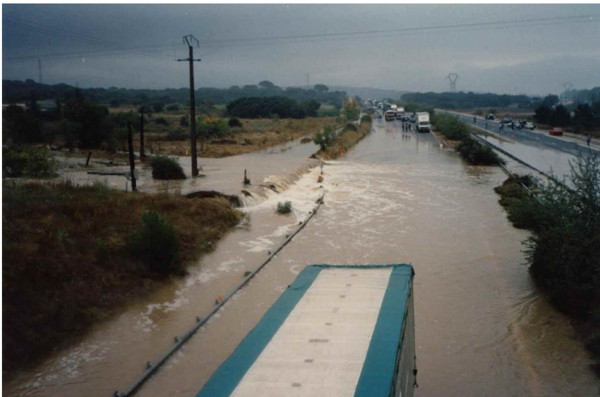
Sur les coteaux, la Vallongue coupe l'autoroute A9 à Bernis en octobre 1988 (cliché Les Amis de Bernis).
