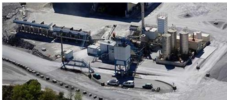
Photographie d'une centrale d'enrobage fixe
